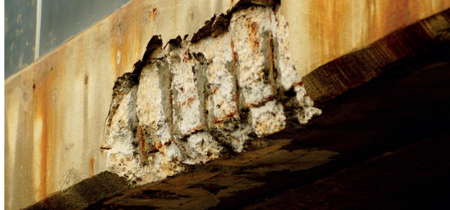
Betonabplatzung an einer Brücke als Folge von schädlichem Wassereintrag in Infrastrukturbauwerken
