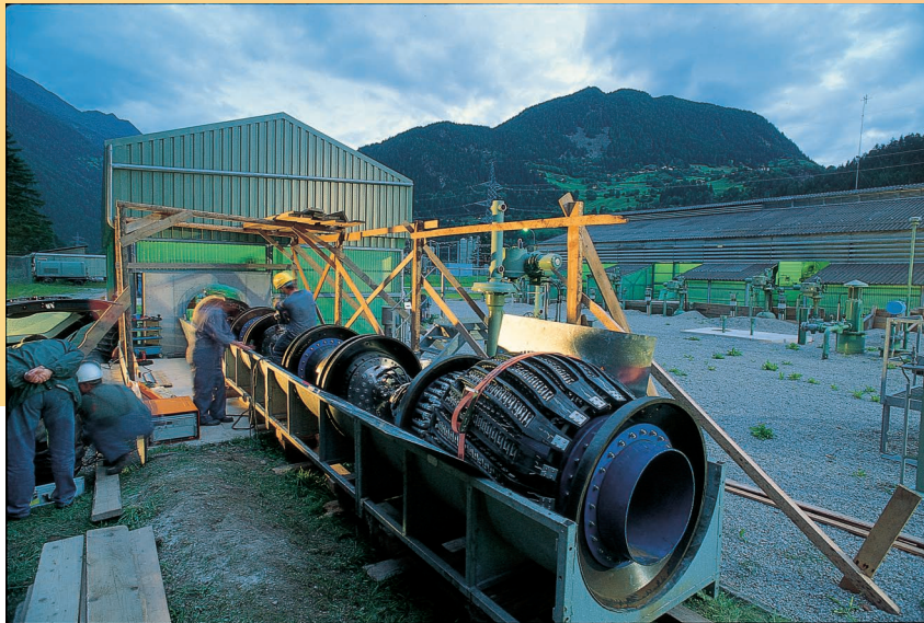
Entwicklung von Prüfmolchen zur Pipelineprüfung (Jahrtausendwende)
