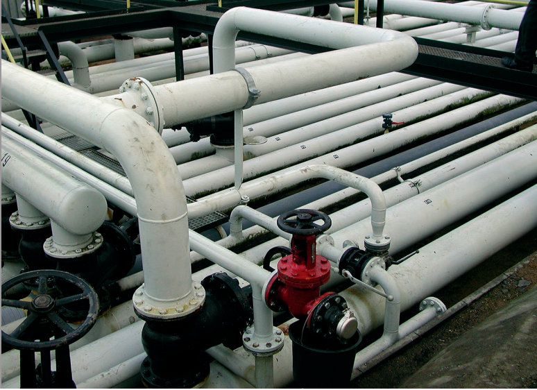
Rohrleitungen in einer petrochemischen Fabrik
